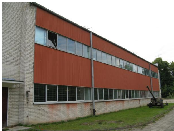
Elewacja budynek B
