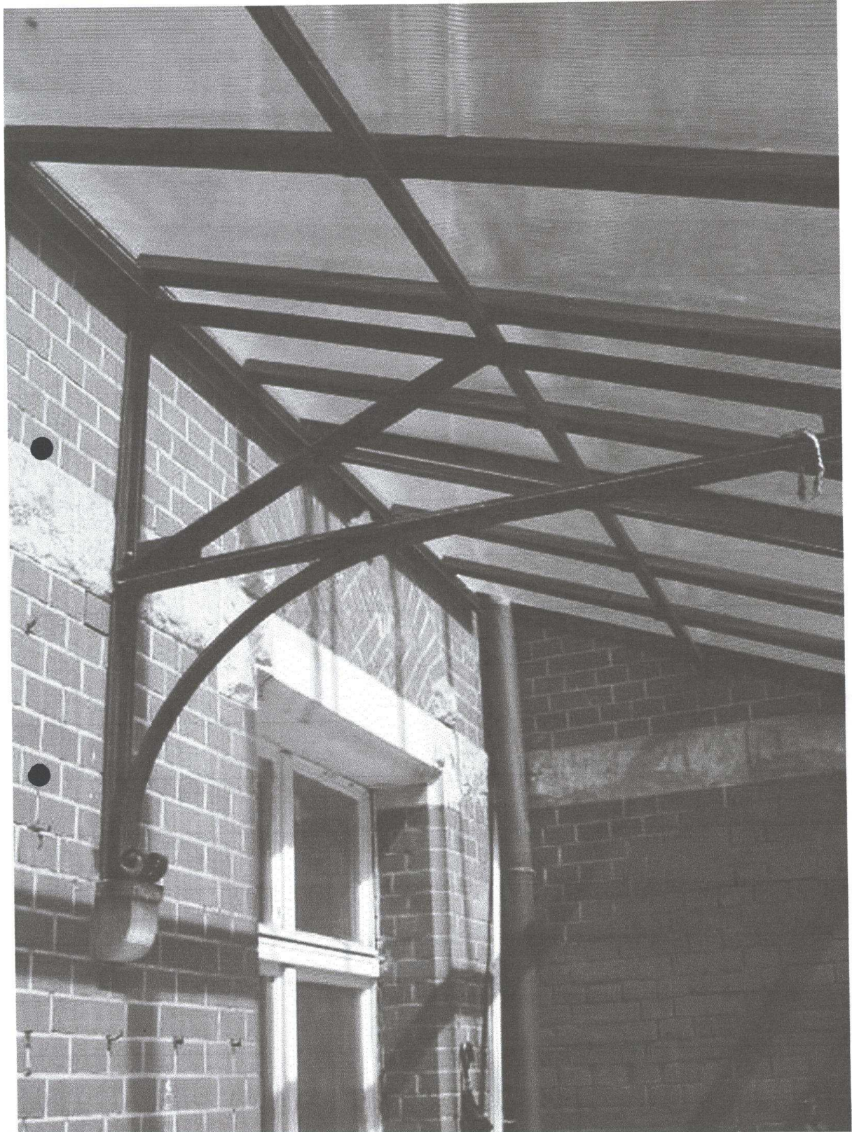
Fot. Nr 5. Gmach Chemii „A”. Wejście od strony dziedzińca. Istniejące zadaszenie.
