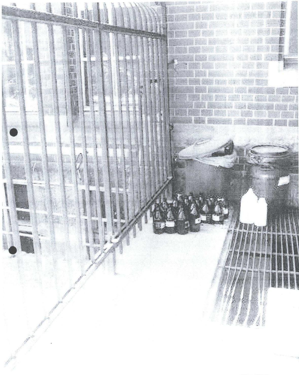
Fot. Nr 4. Gmach Chemii „A”. Wejście od strony dziedzińca. Istniejąca posadzka do wymiany i istniejąca krata stalowa do renowacji.
