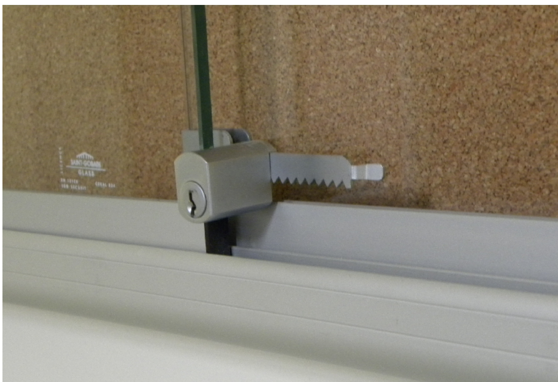
Detal 2 gabloty – zamek bębnowy zamykający przesuwane szyby
