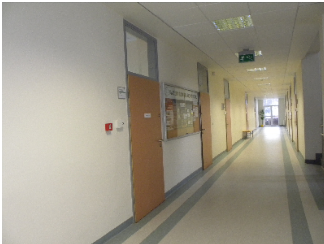
Widok fragmentu korytarza (po remoncie) 1 piętra z gablotą
