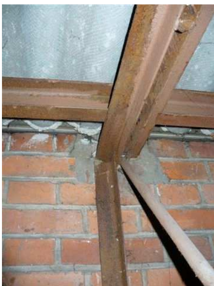
Foto 3. Miejsce osadzenia pasa górnego dźwigara w ścianie budynku Hydromechaniki. Widoczna płatew i pokrycie z eternitu. Ściana budynku Hydromechaniki w pierwotnym licu z cegły spoinowanej. Poniżej pasa dolnego dźwigara ściana ta została pokryta tynkiem.
