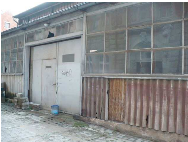
Foto 2. Fragment ściany podłużnej osłonowej, w której wbudowane są słupy nośne wspierające kratowe dźwigary dachowe. Widoczny pas podokienny wykończony z płyt eternitu falistego.
