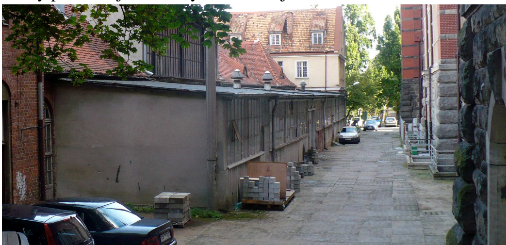
Foto 1. Przybudówka do budynku Hydromechaniki, widok ściany szczytowej i zewnętrznej podłużnej. Po prawej fragment budynku głównego PG.
