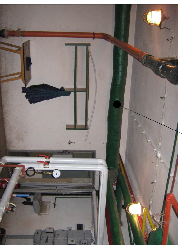
foto. 7 TRASA UKŁADANIA PROJEKTOWANEJ SIECI 2xØdn190
