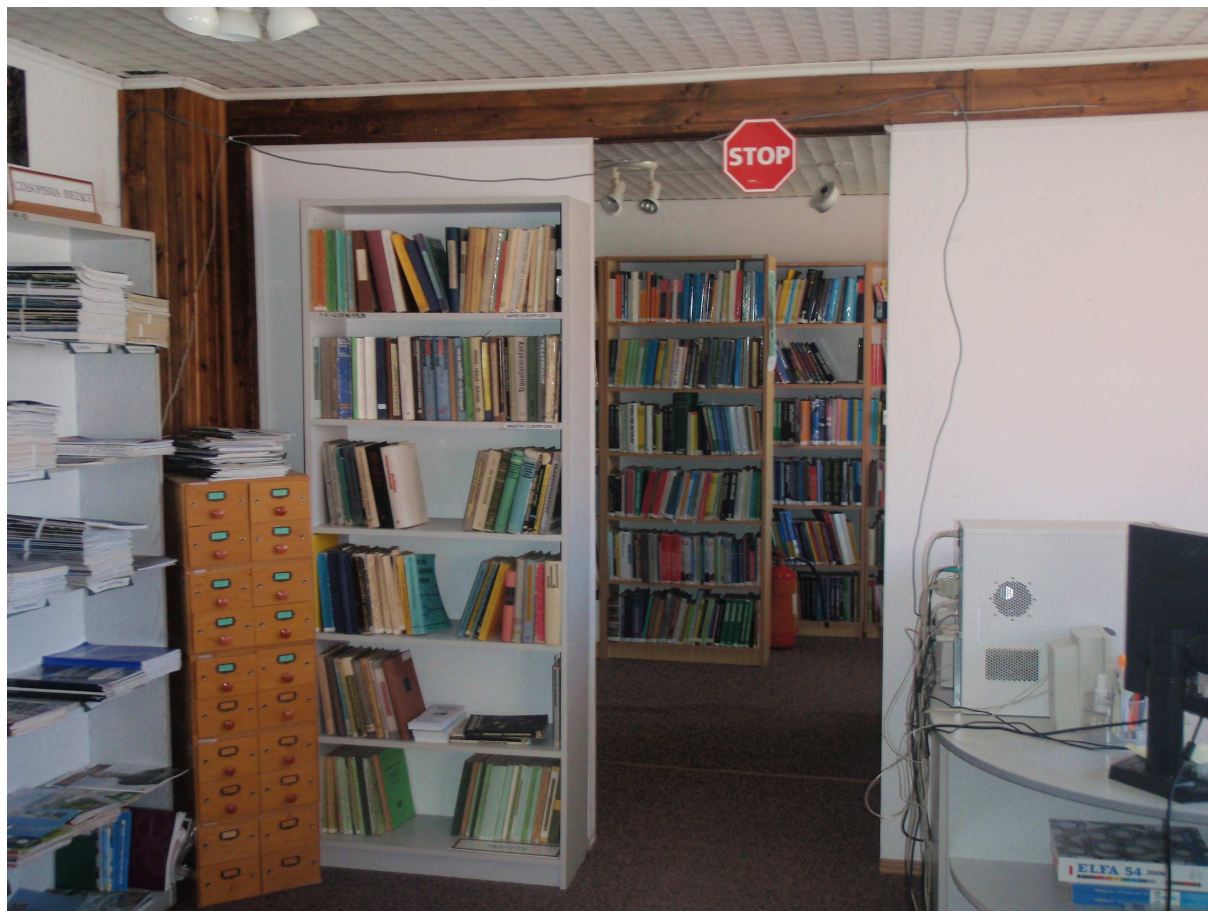
Rysunek 2. Widok pomieszczenia 44 Pawilon NRD (ścianki do demontażu)
