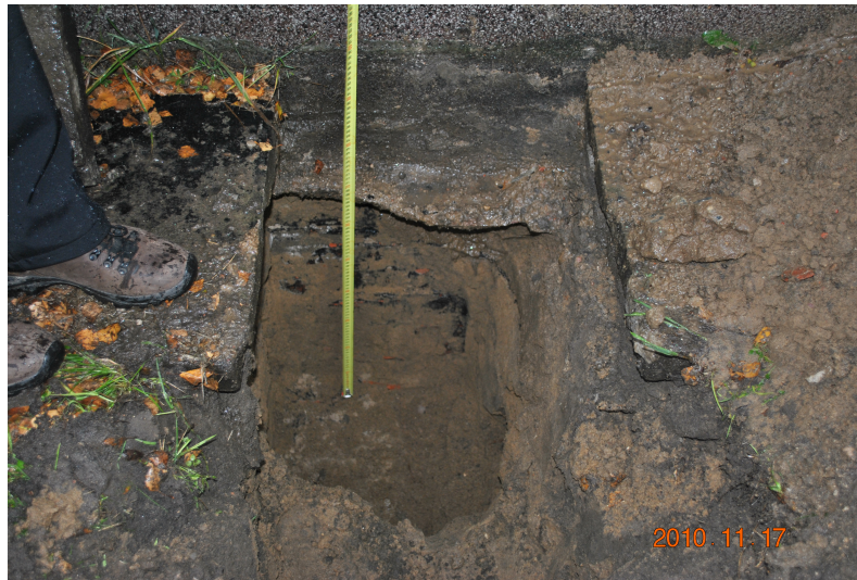
Fot. 1 Odkrywka stopy fundamentowej w osi 7
