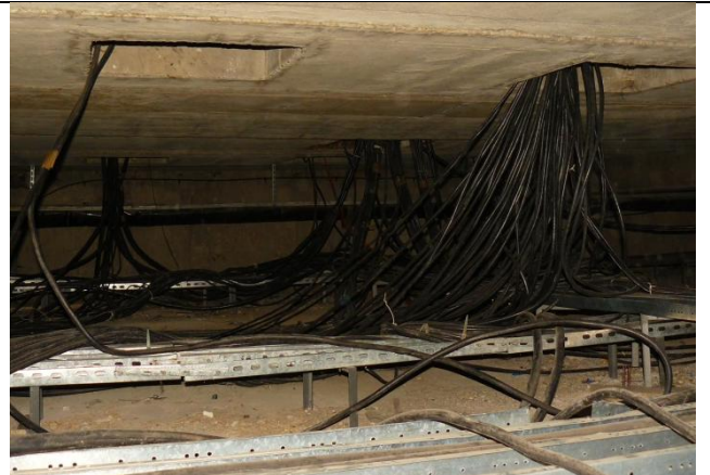
Fot. 12. Przyłącze rozdzielnic i studzienki przyłączeniowej - do przebudowy
