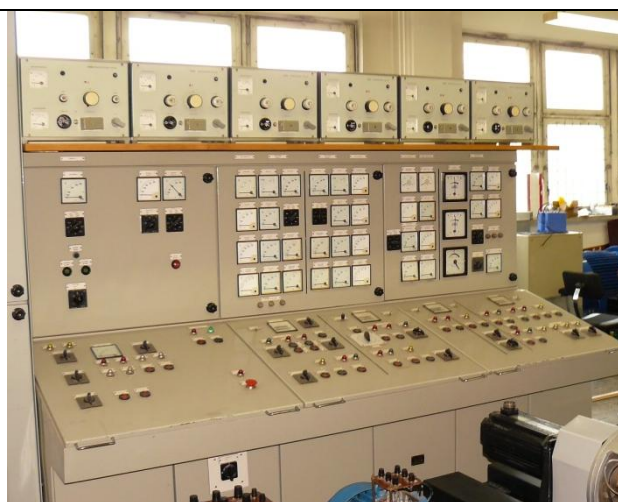
Fot. 2. Pomieszczenie C01 - pulpit do demontażu
