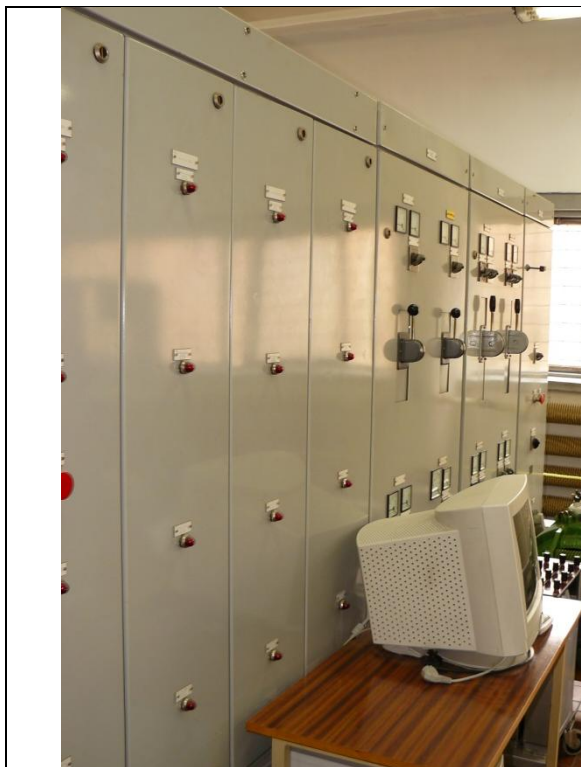
Fot. 5. Hala H01 - rozdzielnica K2 - do demontażu
