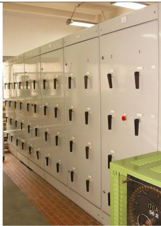
Fot. 6. Hala H01 - rozdzielnica K2 - do demontażu
