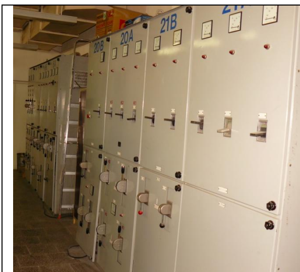
Fot. 1. Pomieszczenie C01 - część rozdzielnic 1RL - do demontażu
