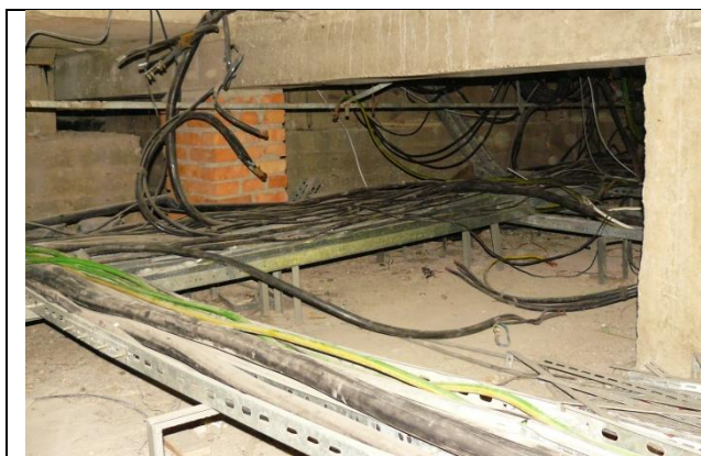
Fot. 7. Galeria kablowa w podpiwniczeniu - do przebudowy
