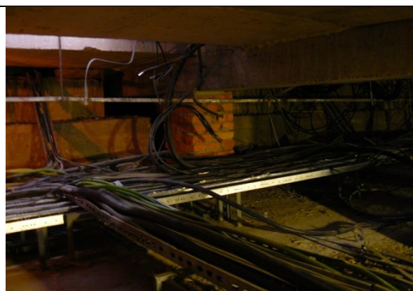
Fot. 8. Galeria kablowa w podpiwniczeniu - do przebudowy
