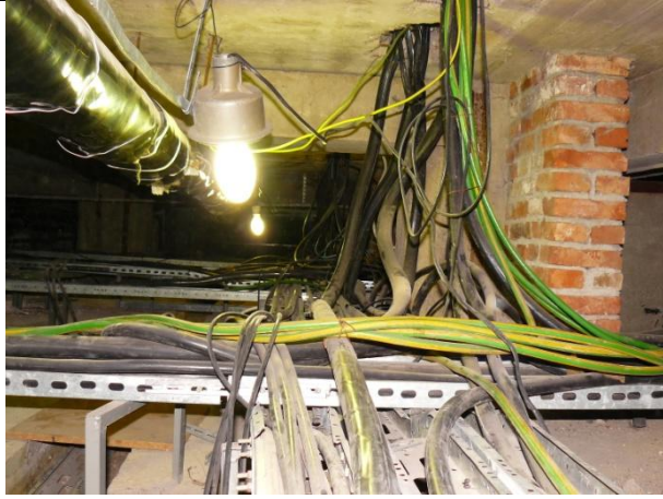
Fot. 9. Galeria kablowa w podpiwniczeniu C01 - do przebudowy
