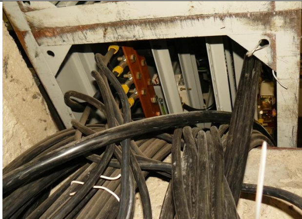
Fot. 11. Przyłącze rozdzielnic - do przebudowy
