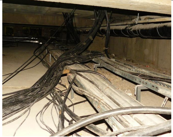
Fot. 10. . Galeria kablowa w podpiwniczeniu H01 - do przebudowy
