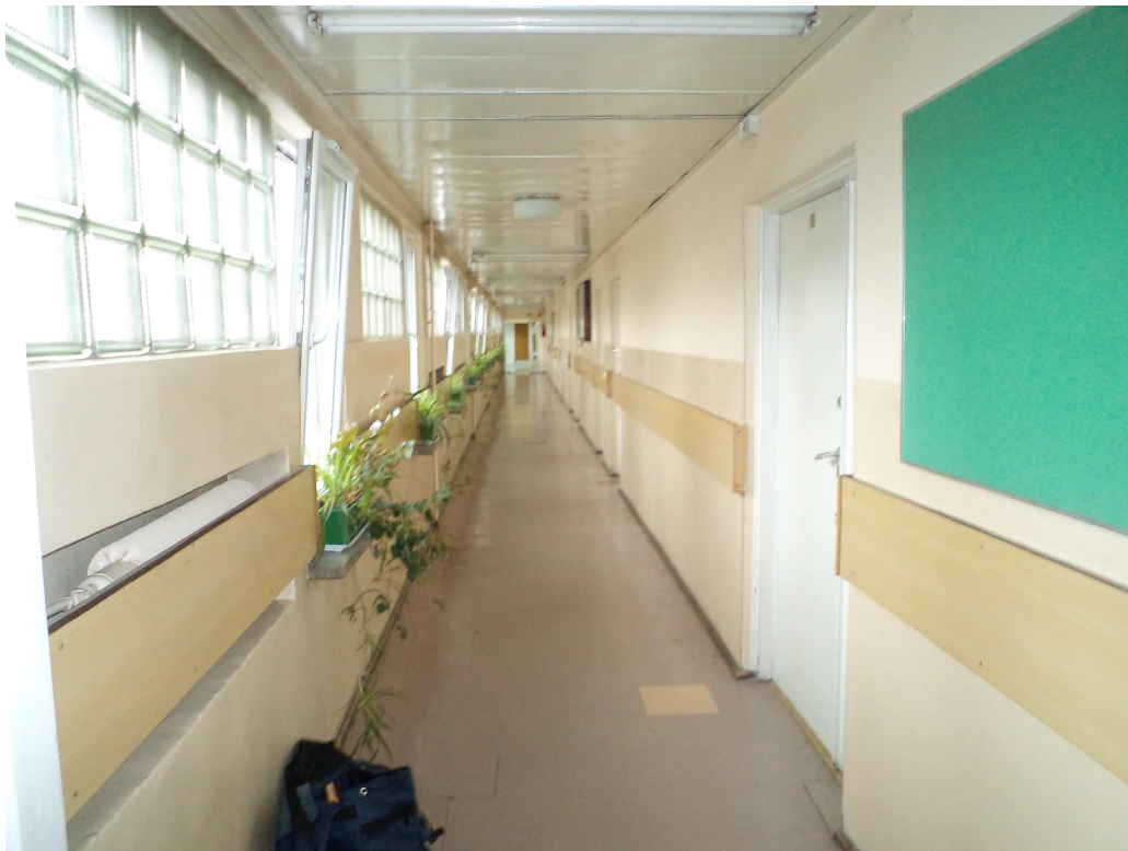
Rysunek 2. Widok korytarza II piętra niskiej części
