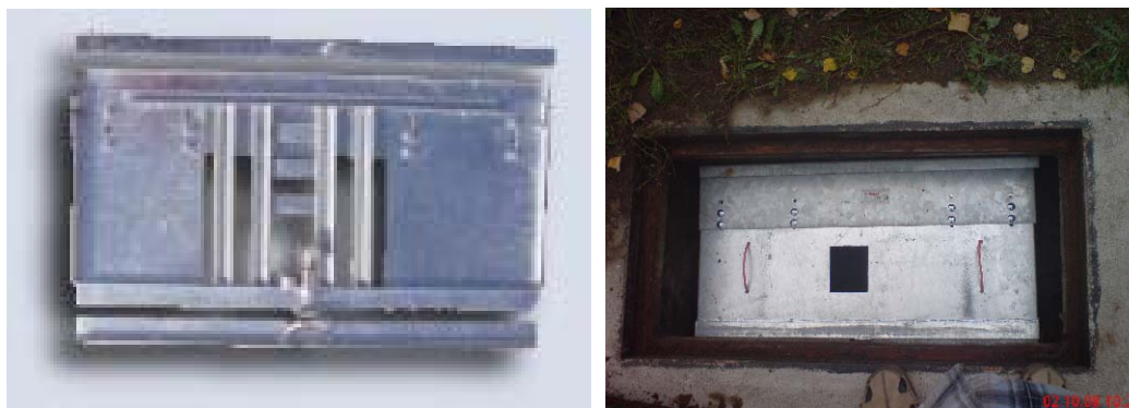
Rys. 2 Wewnętrzne zabezpieczenie studni.
