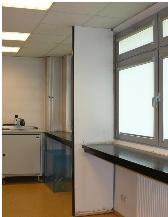
Fot. nr 2. Ścianka działowa i parapety przeznaczone do demontażu
