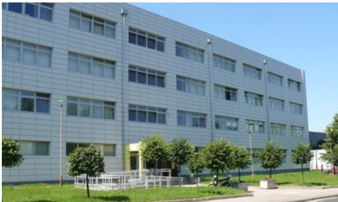
Fot. nr 1 - Budynek przy ul. Sobieskiego 7, w którym zlokalizowane jest pomieszczenie EM113
