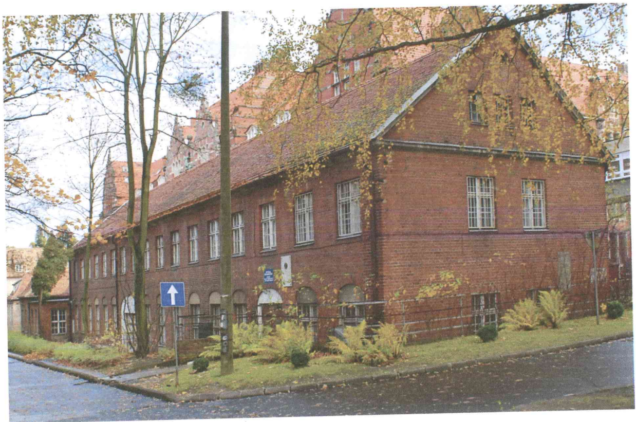
Fot. 4 Elewacja zachodnia, część południowa i elewacja południowa
