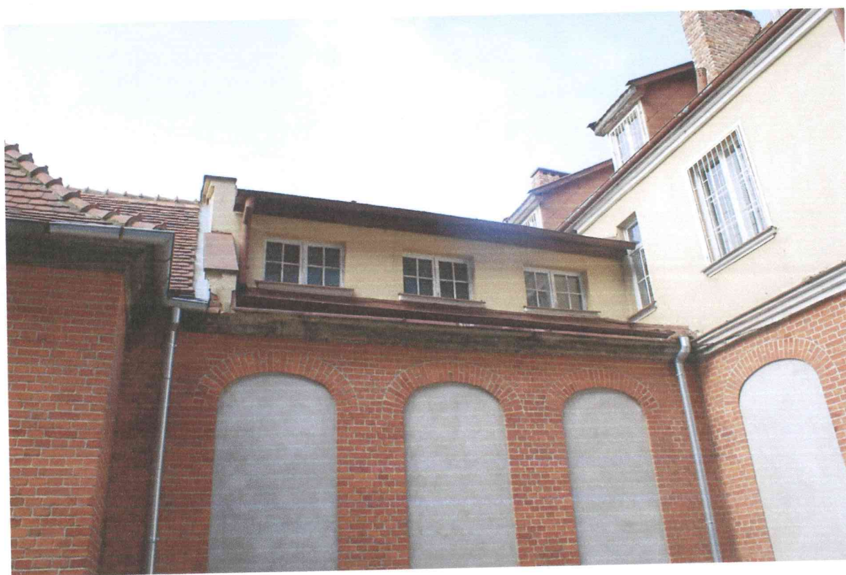
Fot. 8 Elewacja wschodnia, część północna
