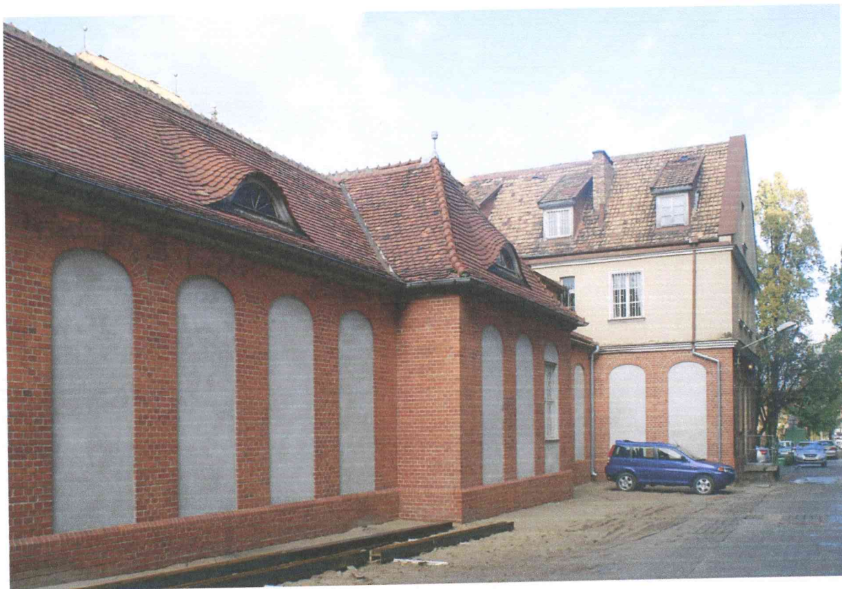
Fot. 7 Elewacja wschodnia, część środkowa i północna
