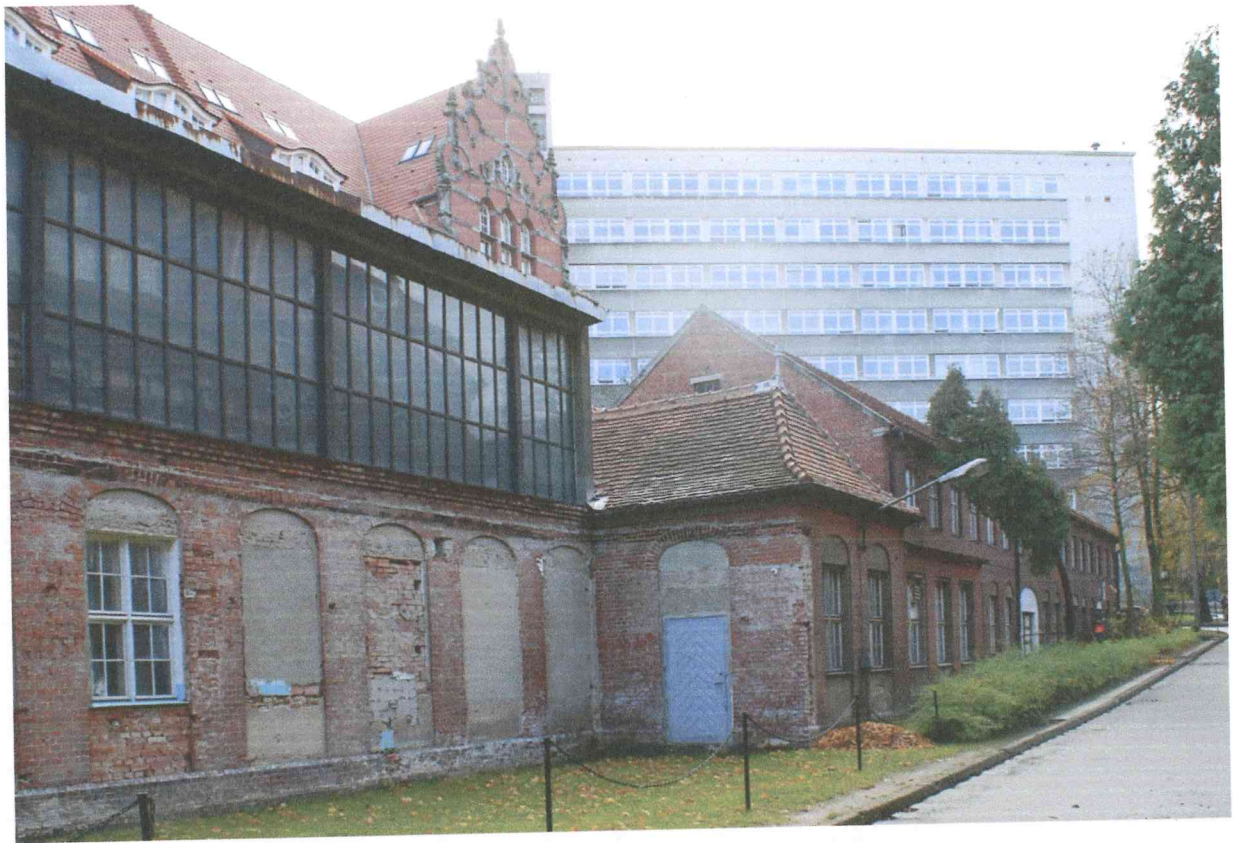
Fot. 3 Elewacja zachodnia, część środkowa i południowa
