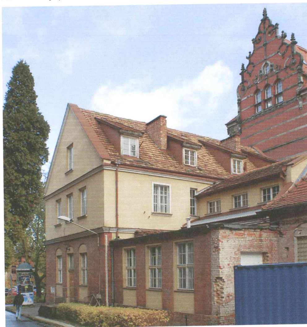
Fot. 2 Elewacja zachodnia, część północna
