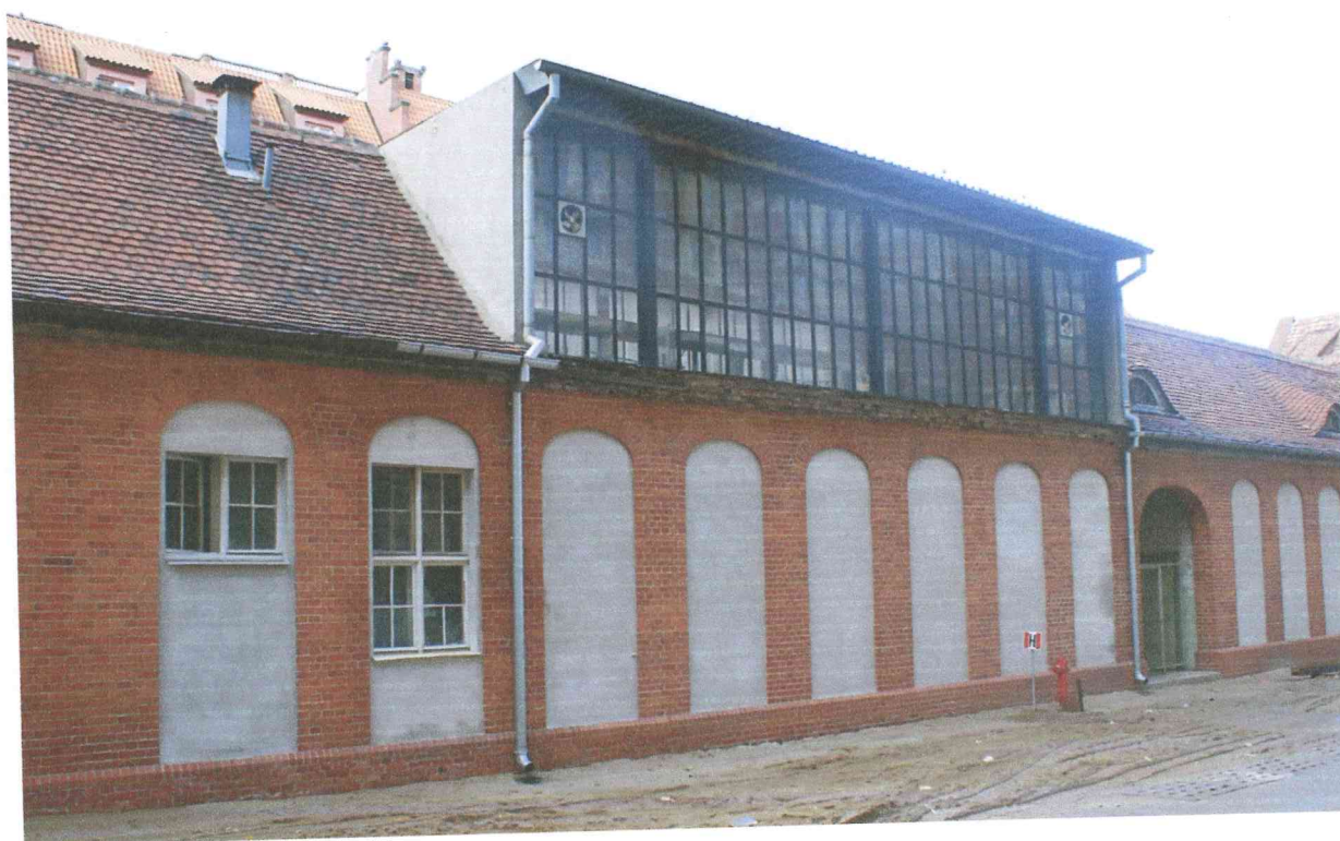
Fot. 6 Elewacja wschodnia, część środkowa
