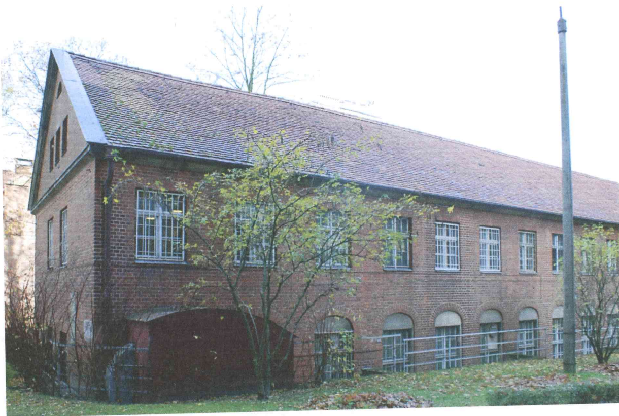
Fot. 5 Elewacja wschodnia, część południowa
