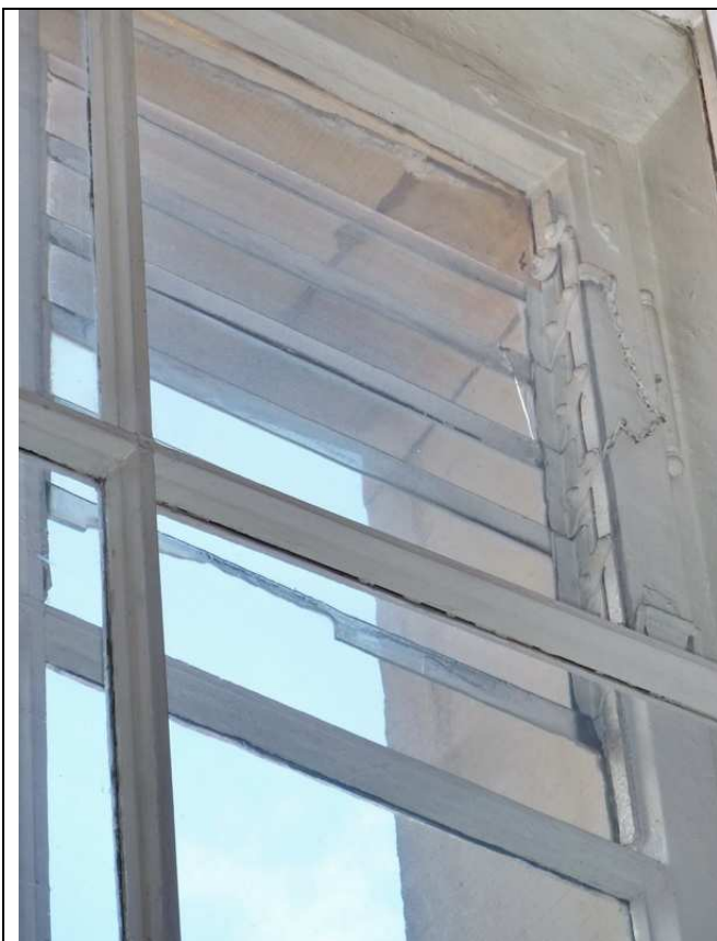
9. Żaluzja w polu pomiędzy szczelinami skrzydła zewnętrznego
