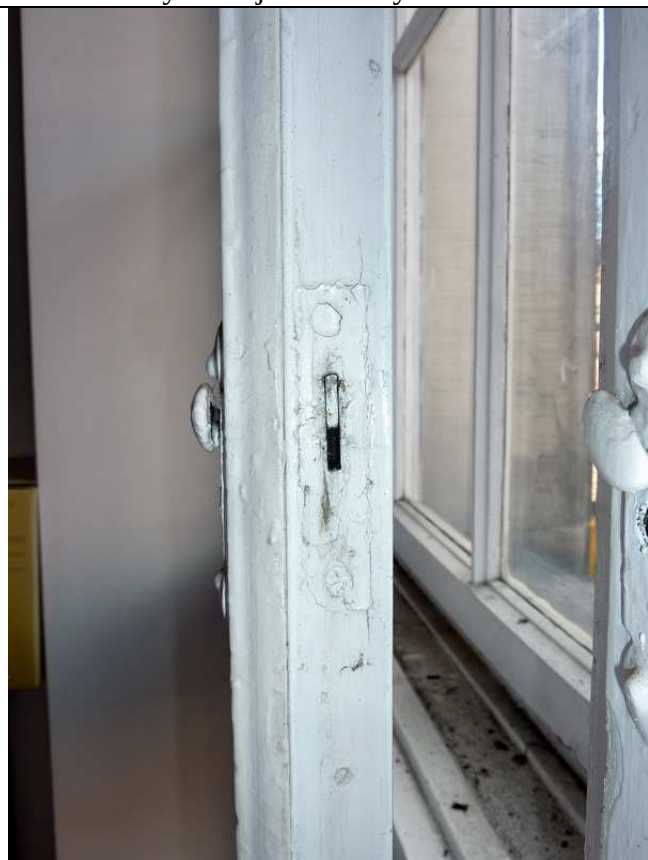
8. Detal okucia zamykającego górne skrzydło.
