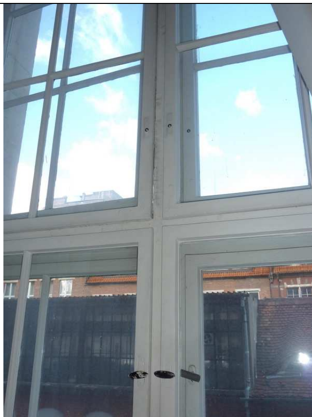
12. Okno wtórne z prostymi klamkami i narożnikami wpuszczanymi. Szprosy znacznie szersze niż oryginalne.
