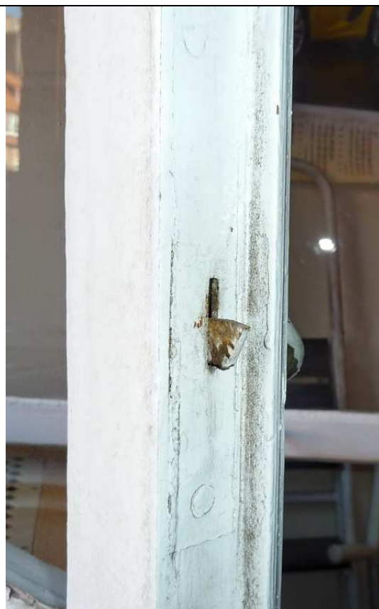
6. Detal zabytkowej zasuwicy
