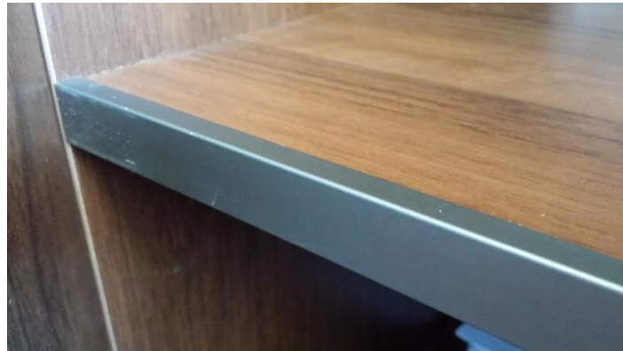
Fot. 1 Wzmocnienie półki ceownikiem aluminiowym.
