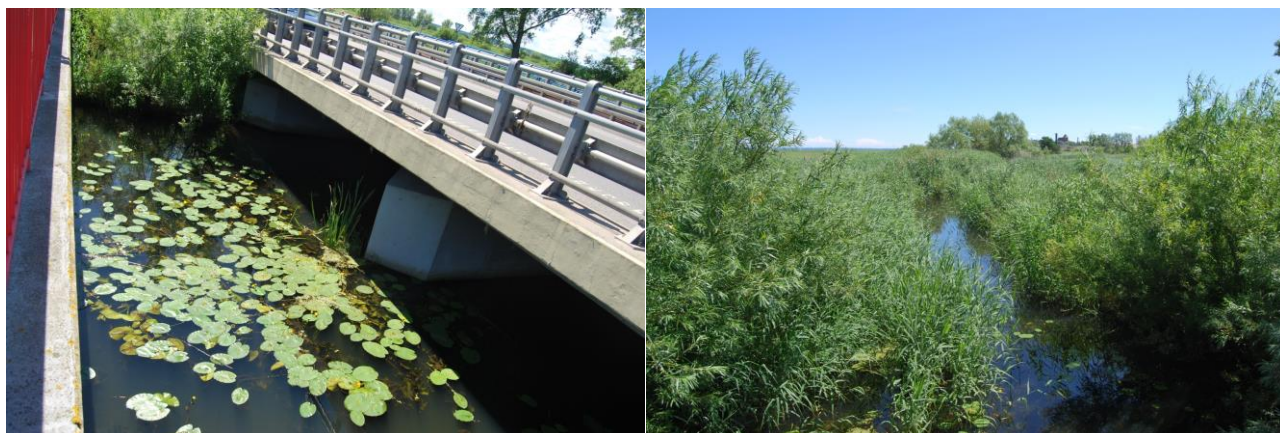
Fot. 2. Punkt pomiarowy nr 2 - widok mostu i koryta od strony WG
