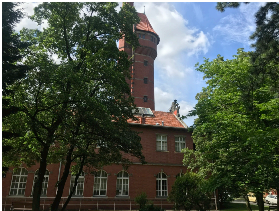
Fot.3. Elewacja boczna budynku Laboratorium Maszynowego – fragment, 2019r.
