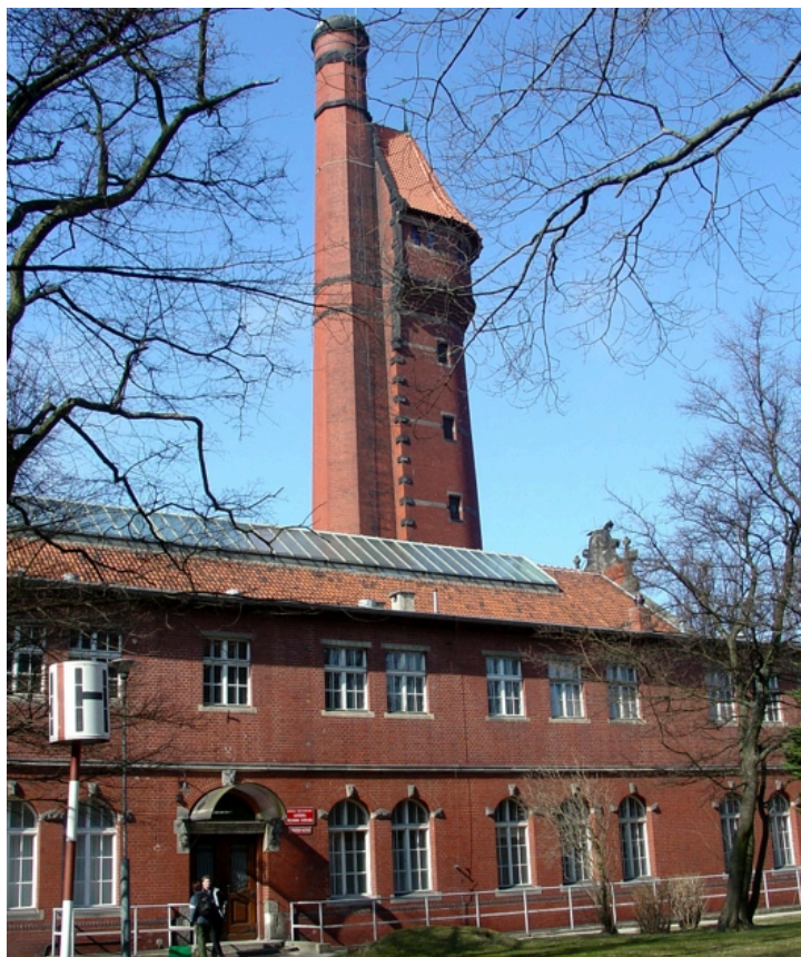
Fot.7. Elewacja boczna od strony wschodniej – portal przeznaczony do remontu
