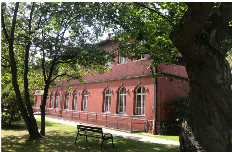
Fot.4. Elewacja boczna budynku Laboratorium Maszynowego – fragment, 2019r.
