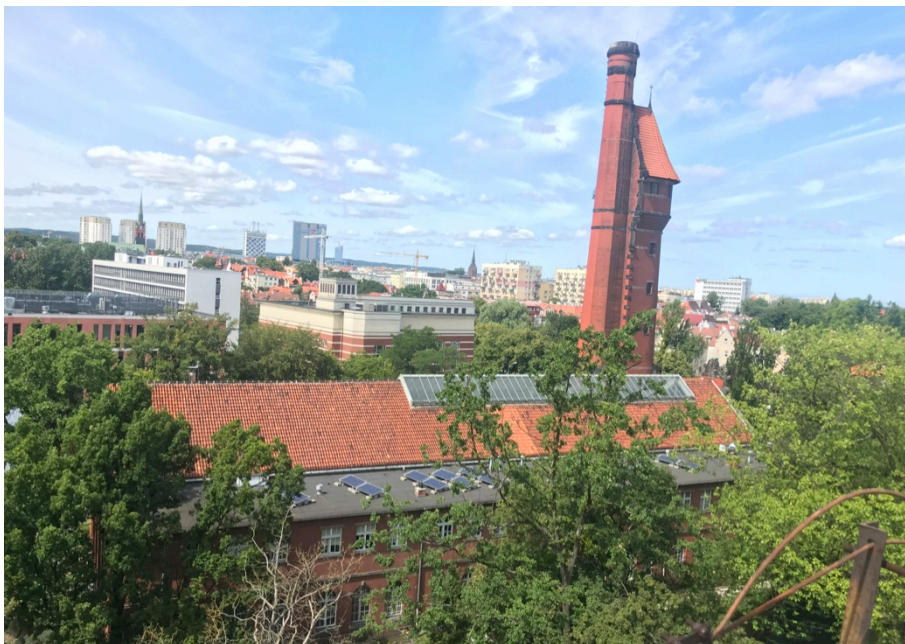
Fot.1. Dach hali Laboratorium Maszynowego, widoczny komin i wieża ciśnieniowa, 2019 r.
