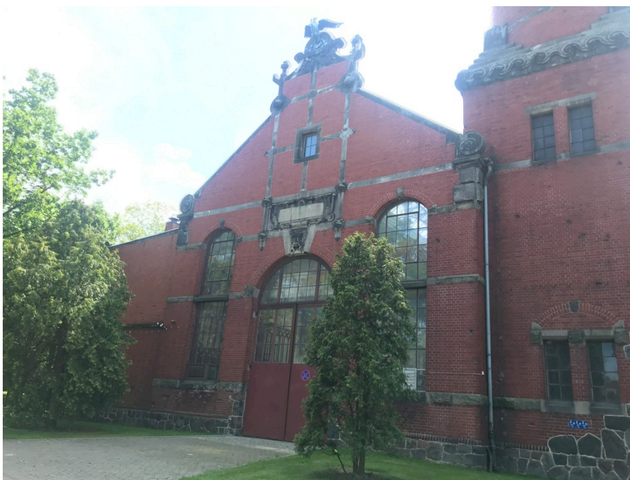
Fot.2. Neorenesansowa elewacja frontowa hali z widocznym fragmentem wieży ciśnieniowej, 2019r.
