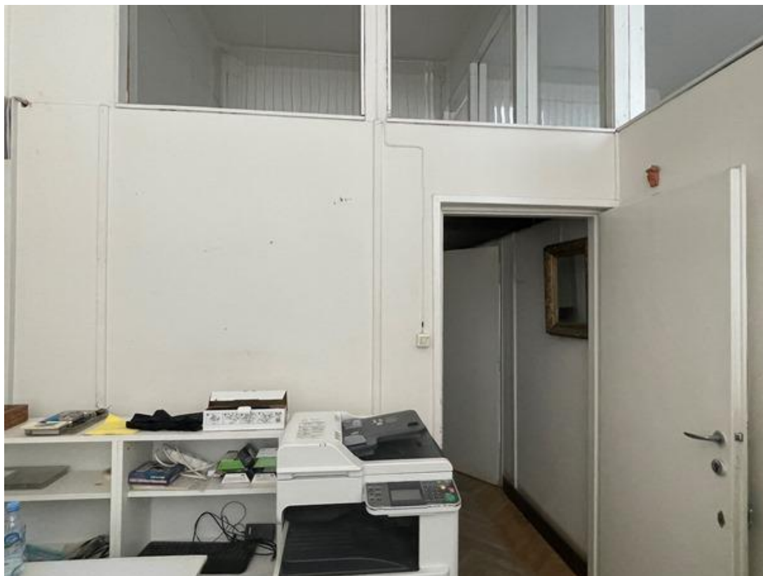
Ryc. 5 Wnętrze pomieszczenia nr 309 – fragment drewnianej ścianki.
