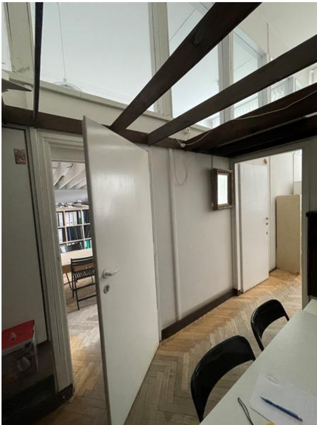
Ryc. 2 Wnętrze pomieszczenia nr 309 – fragment drewnianej ścianki oraz konstrukcji sufitowej.
