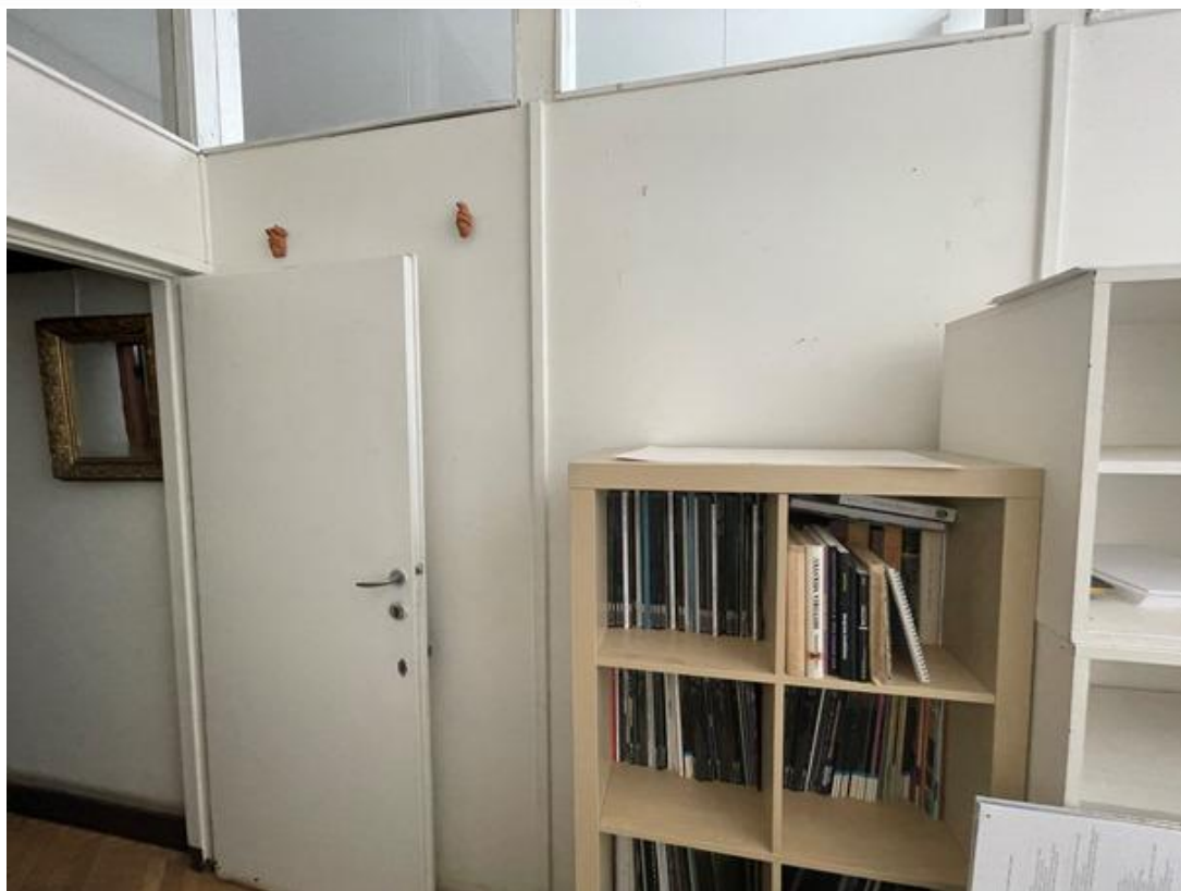
Ryc. 3 Wnętrze pomieszczenia nr 309 – fragment drewnianej ścianki.
