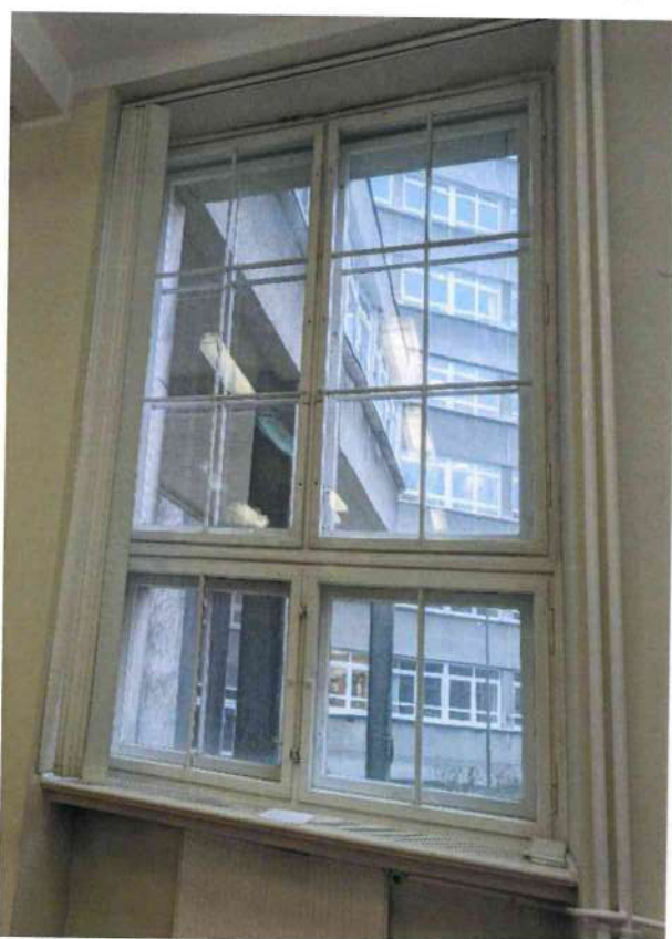
fot. 2 Zabytkowe okno skrzynkowe typu O1, rewers, stan obecny.
