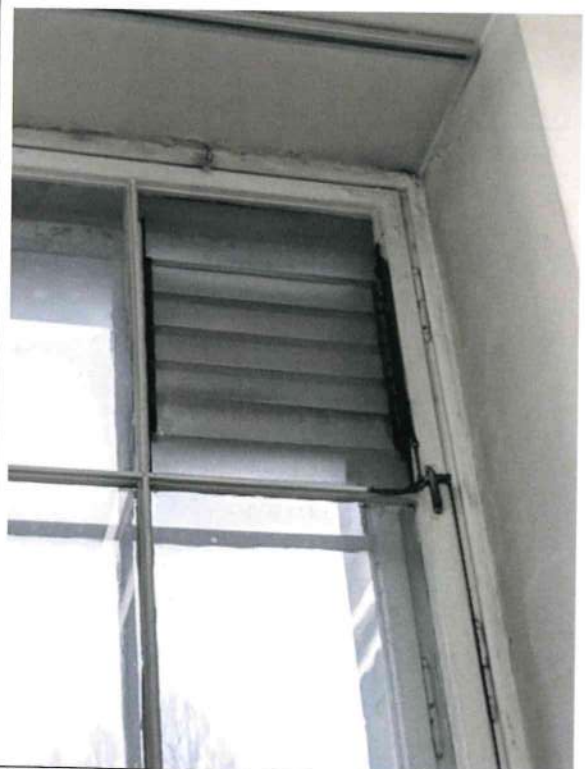
fot. 7 Widoczne żaluzje szklane w skrzydle wewnętrznym okna.
