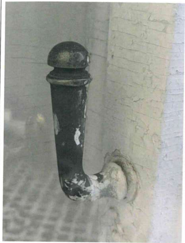
fot. 5 klamka okienna typu L, zamykająca skrzydła zewnętrzne okna
