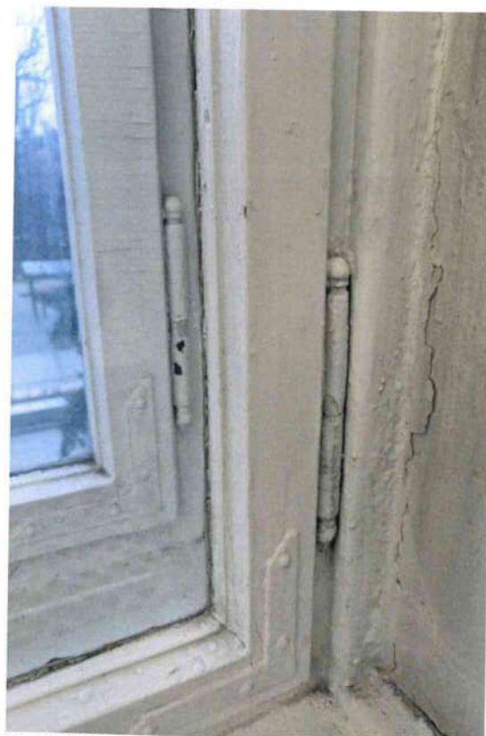
fot. 3 Widoczne oprofilowanie ramiaków oraz kątowniki okienne i zawiasy, stan obecny
